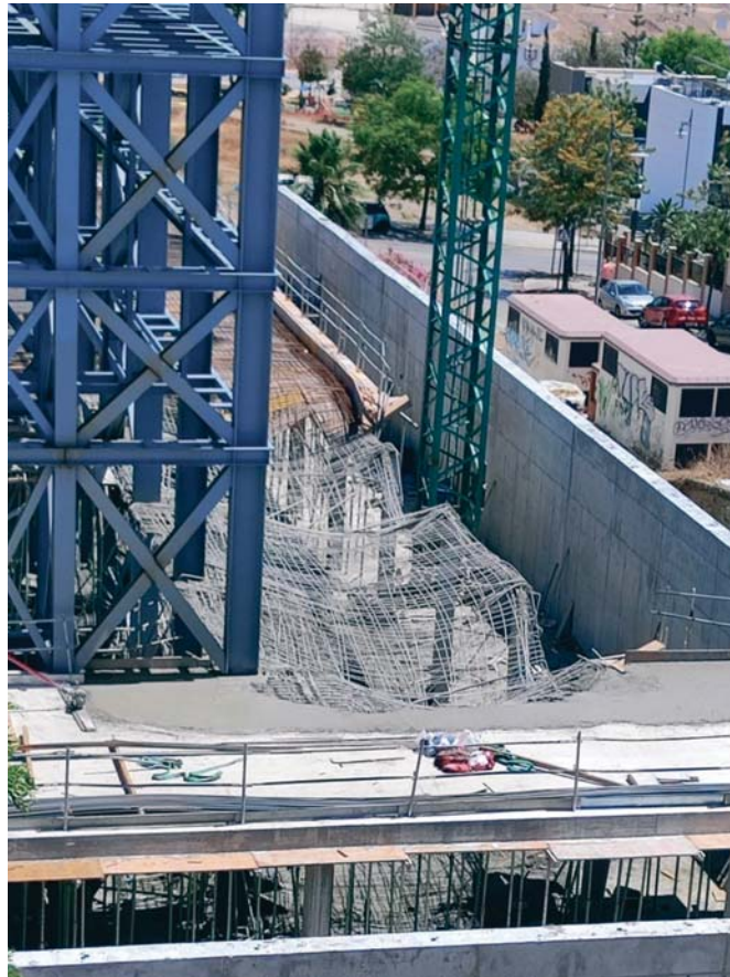
Imagen del fallo en la obra del Teatro de Torre del Mar. VIVA VÉLEZ
